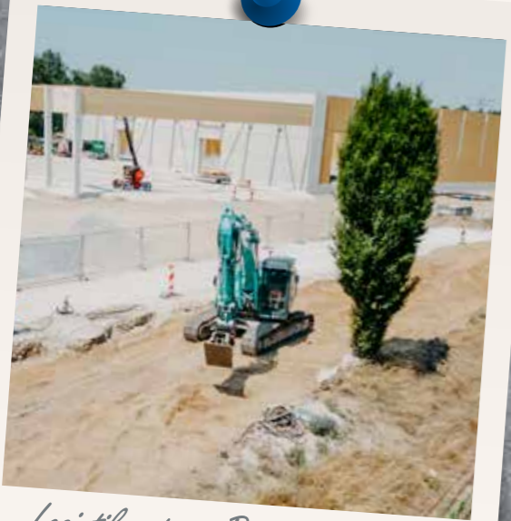
Logistikzentrum Brauerei Kuchlbauer
